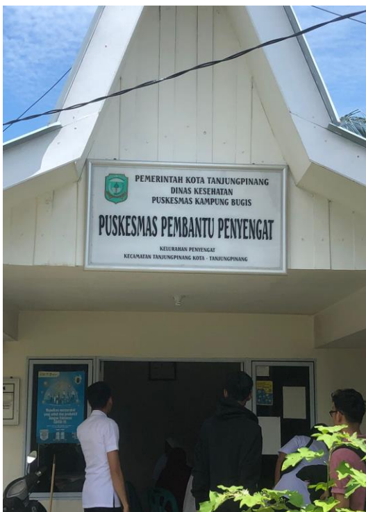
Gambar 2. Pustu Pulau Penyengat (Dok. Peneliti, 2023)
