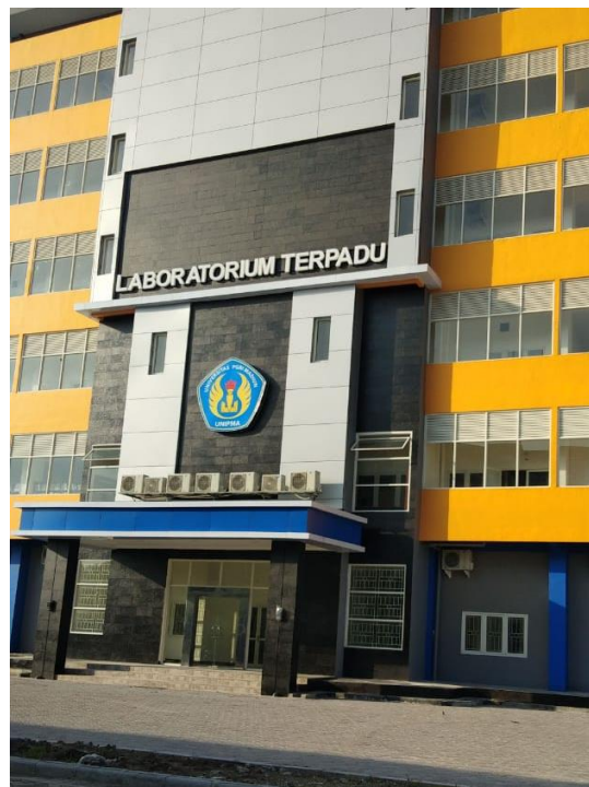
Gambar 4. Lokasi Pemasangan Alat
