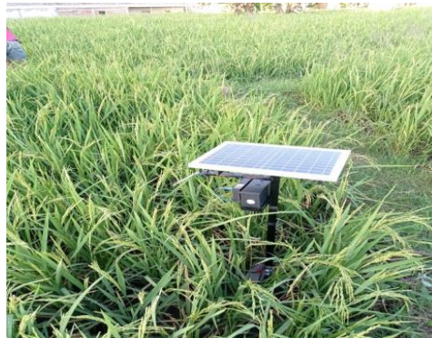
Gambar 5. Perakitan Panel Surya
