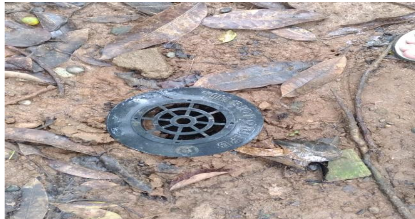
Gambar 4: Penutupan lubang resapan biopori
