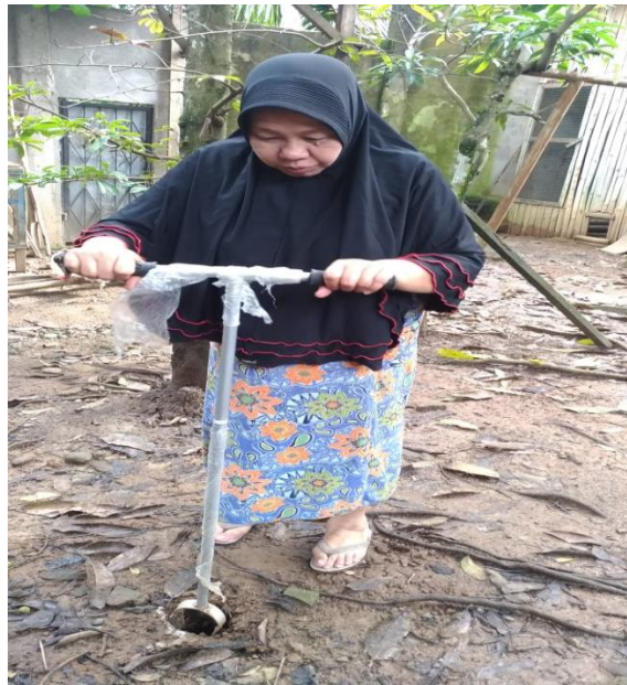
Gambar 3: Proses pembuatan LRB
