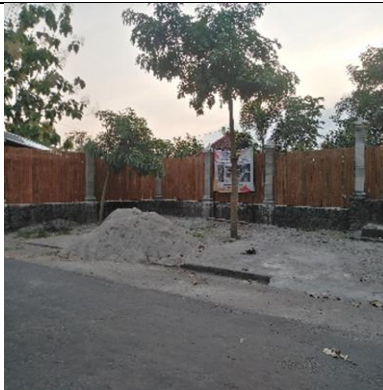
Gambar 12: Pagar Depan Taman Dewi Sri Setelah Diperbaiki dengan Pemasangan Pagar Bambu
